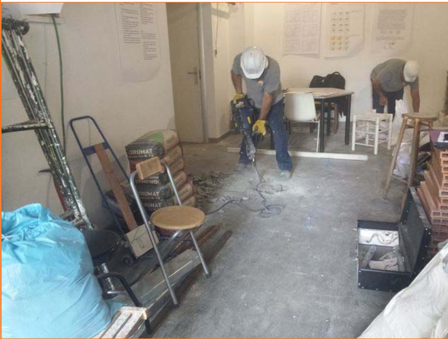
Foto 3. Inici dels treballs de repicat del paviment UE 101. Cala 2.
