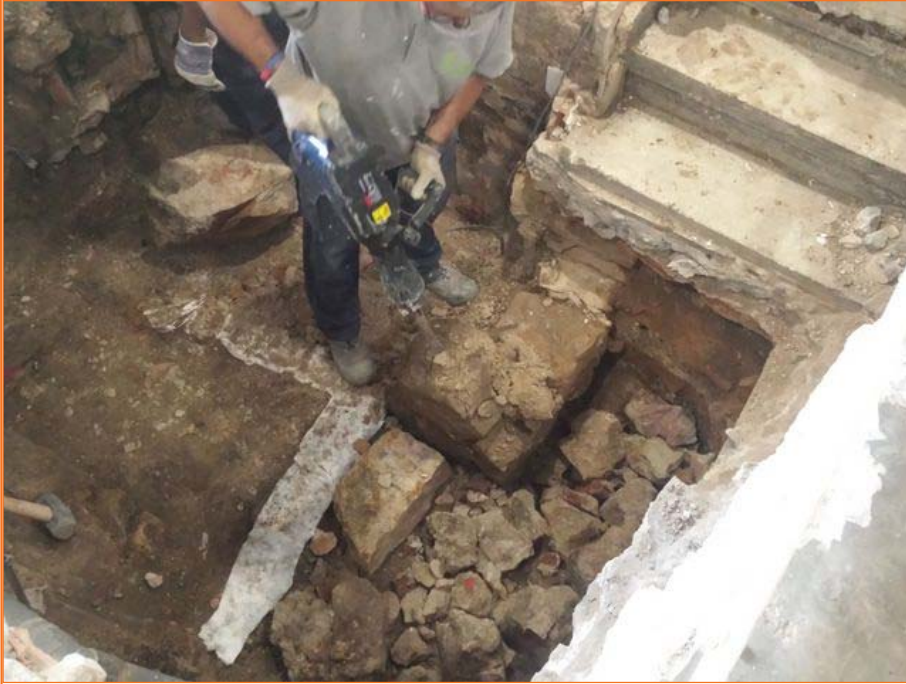
Foto 19. Procés de cobriment i desmuntatge de les estructures afectades. Cala 2.
