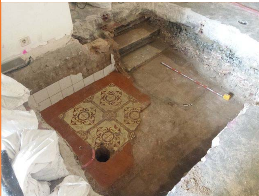
Foto 4. Vista dels paviments UE 104 i 105, amb les escales UE 108 i l'envà UE 109. Cala 2.
