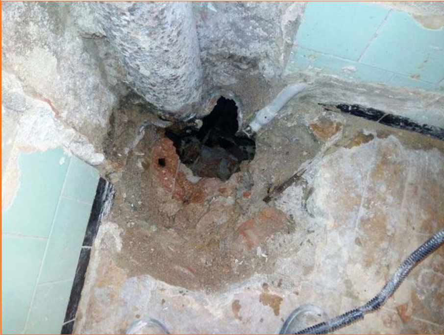
Foto 1. Detall del baixant localitzat a la cala 1 que connecta amb la claveguera UE 111.
